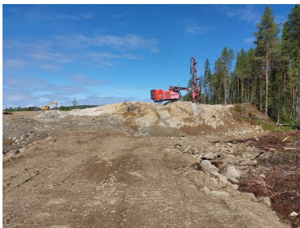
Bilden visar arbetet med förskärning där rampnedfarten skall ligga.
